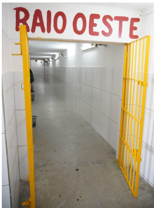
Descrição da imagem: interior do pavilhão reformado
