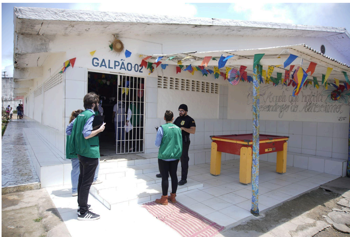
Descrição da imagem: nova construção
