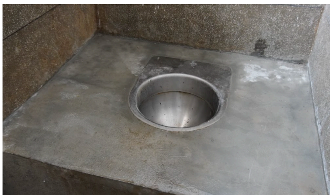
Descrição da imagem: sanitário
