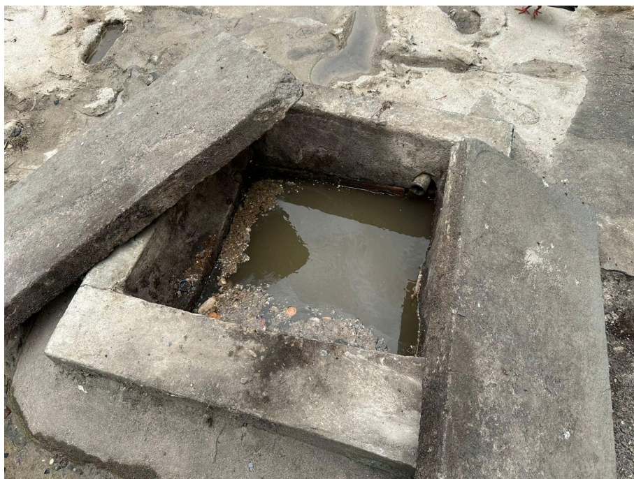
Descrição da imagem: esgoto na área externa
