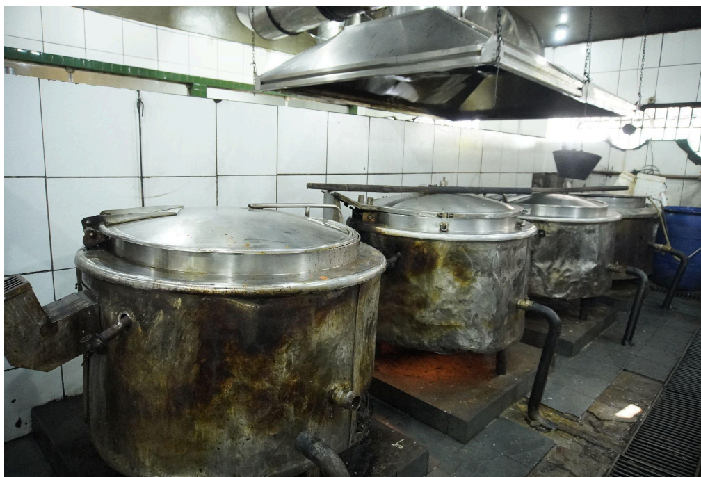
Descrição da imagem: dependências da cozinha
